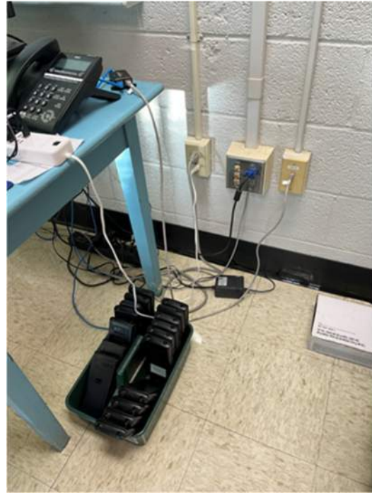
Fig. 10: Insufficient Receptacles
